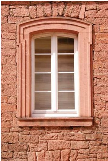
zweiflügeliges Holzfenster in barocker Laibung
