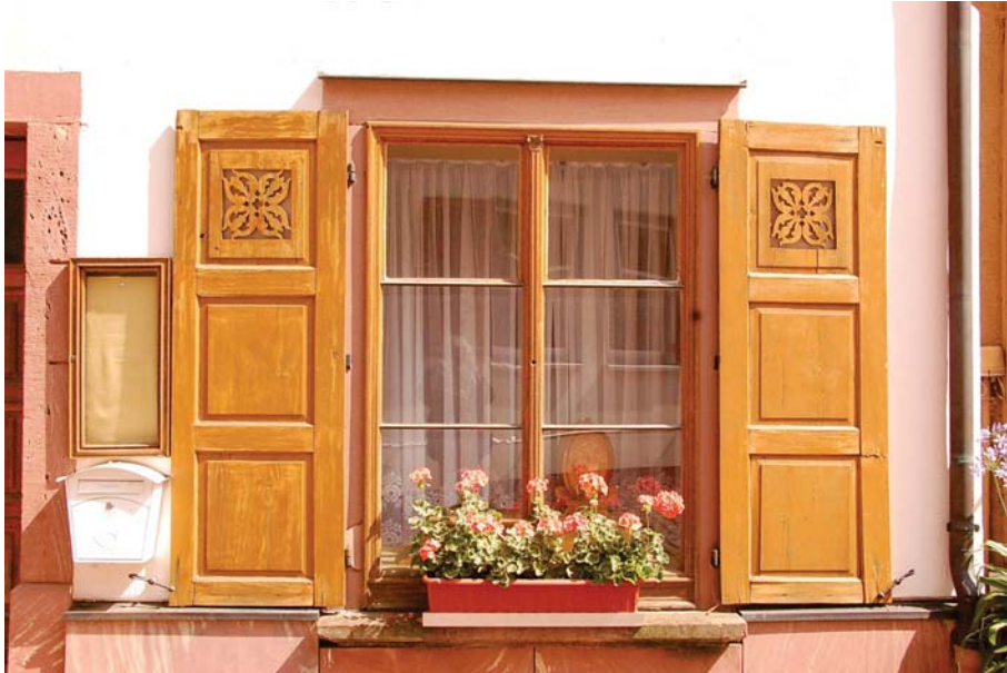
das gesprossste zweiflügelige Holzfenster mit dekorativen Klappläden
