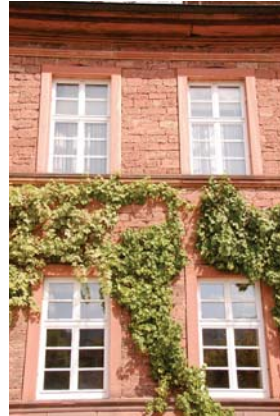
Hausteinfassade heim. Rotsandstein
