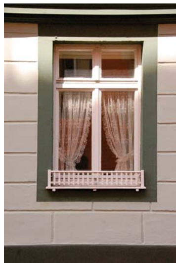
sog. "Galgenfenster" zweiflügelig mit Oberlicht 19. bis fr. 20. Jh.
