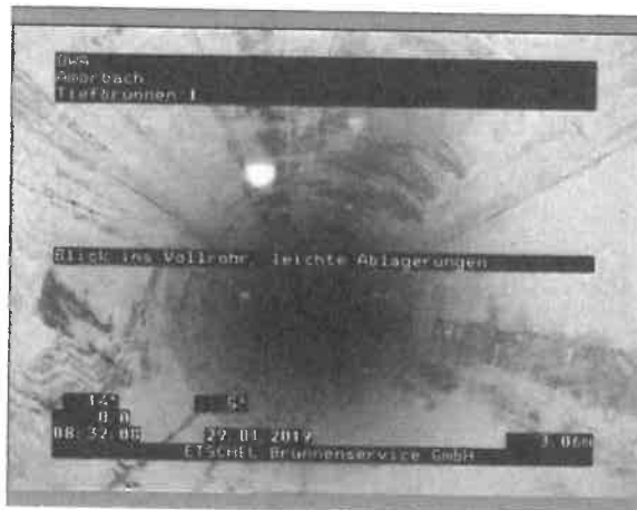
Foto: 1_1_6_29012019_083015_A.JPG 3,06m, Blick ins Vollrohr / leichte Ablagerungen
