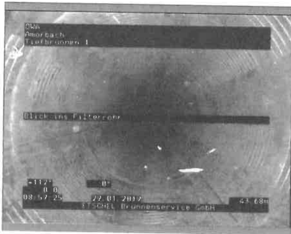
Foto: 1_1_23_29012019_085732_A.JPG 43,68m, Blick ins Filterrohr
