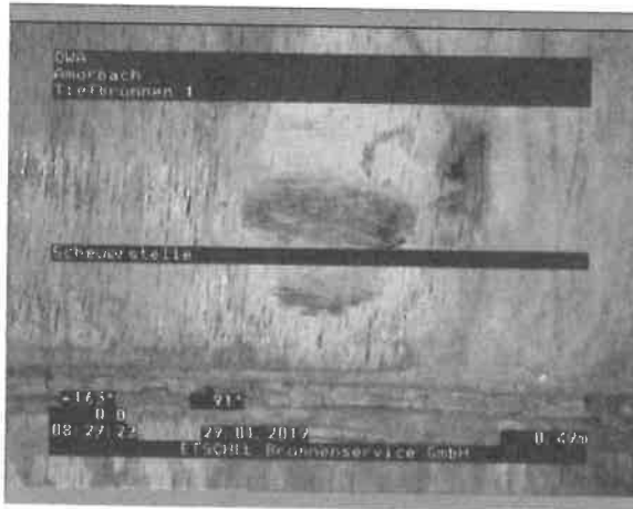
Foto: 1_1_4_29012019_082730_A.JPG 0,49m, Scheuerstelle
