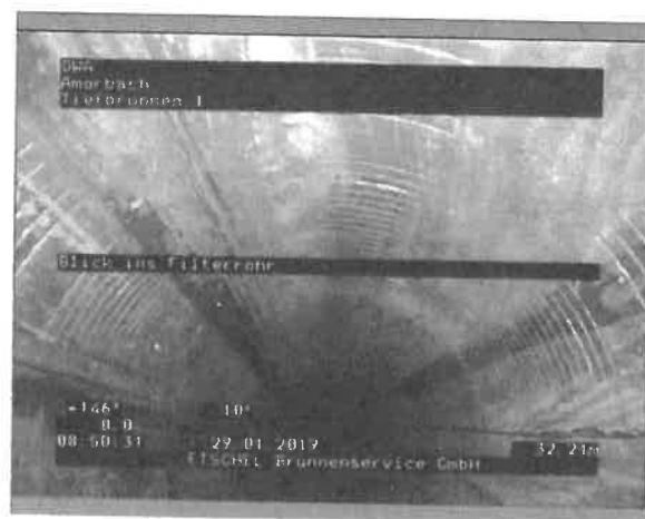
Foto: 1_1_17_29012019_084838_A.JPG 32,21m, Blick ins Filterrohr
