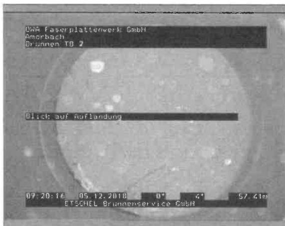
Foto: 1_1_22_A.JPG 57,41m, Blick auf Auflandung
